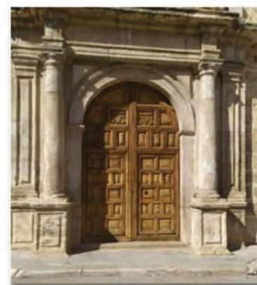
Portón vista Frontal. Fuente: Elaboración propia
