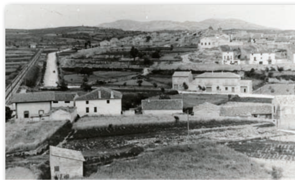
Vista general del barrio de las Peñas desde San Francisco, donde se sitúan varias calles dedicadas a santos (1957).
